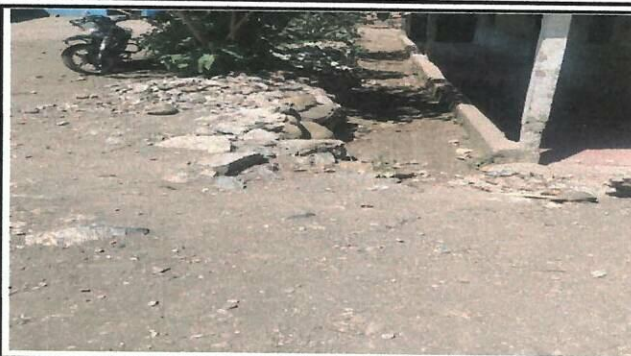
Foto 2: parte del terreno para el remozamiento.
