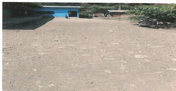
Foto 3: parte frontal del terreno para el remozamiento.
